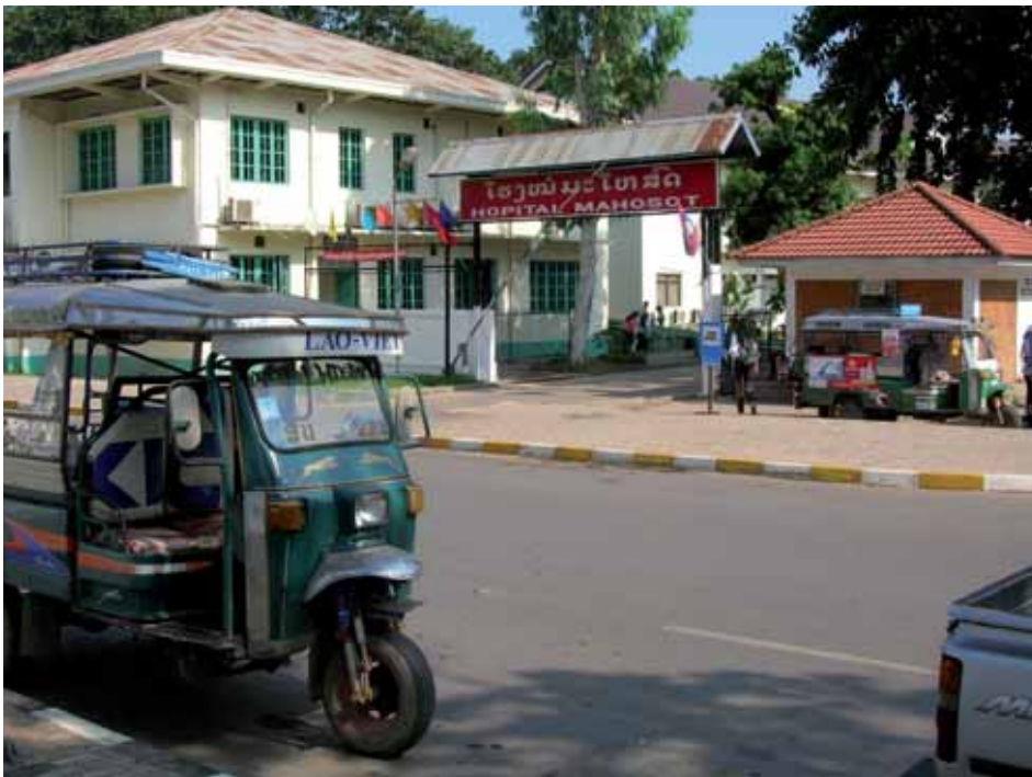
Abb. 1: Haupteingang „Hôpital Universitaire de Mahosot“ in Vientiane
